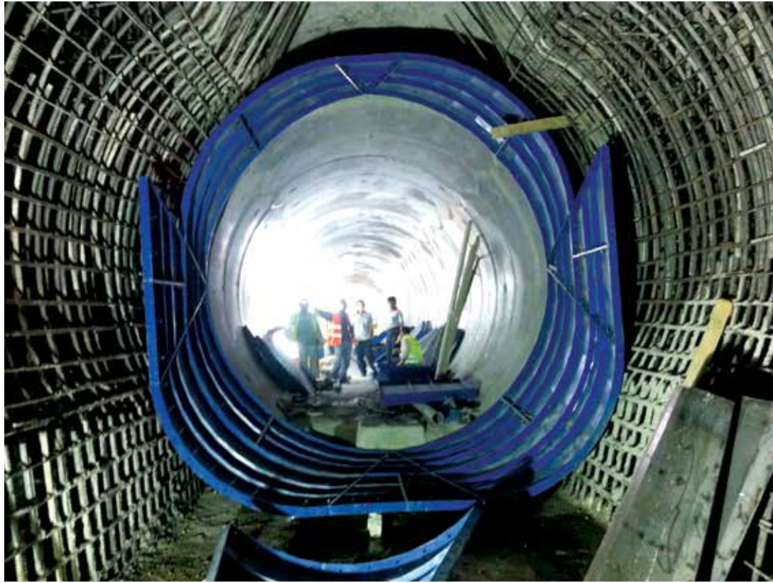
Baraj Tünel Kalıpları
