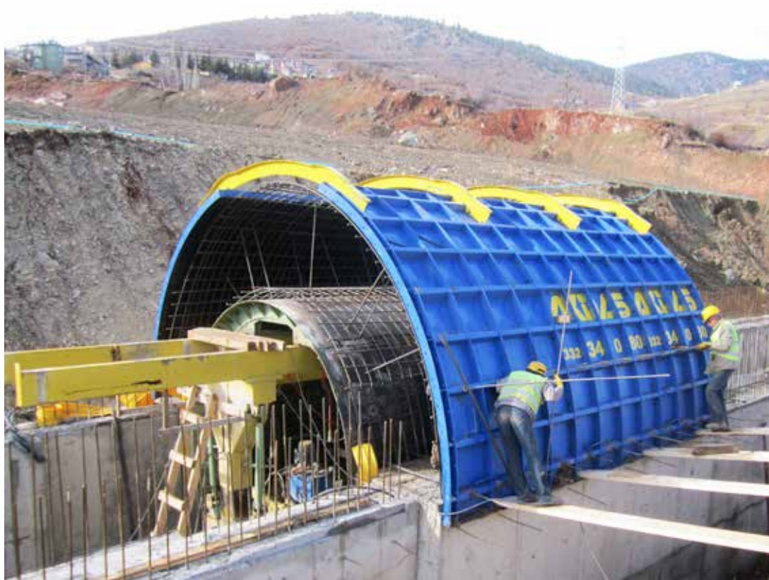
Baraj Tünel Kalıpları
